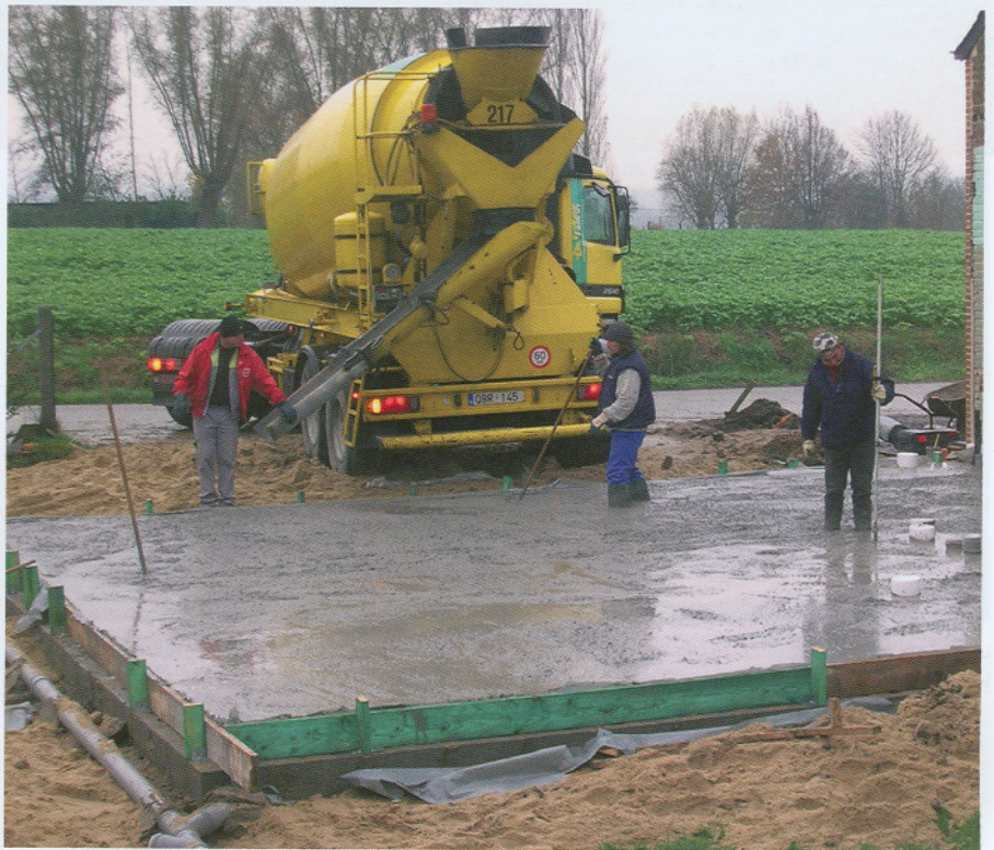
Bij de aanleg van de grondplaat op een bouwplaats kan " Steelex " rechtstreek gegoten worden.
